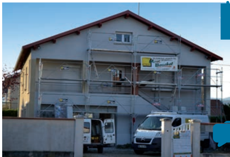
► Maison des associations et des activités périscolaires (MAAP), 1 rue du Chevillon
